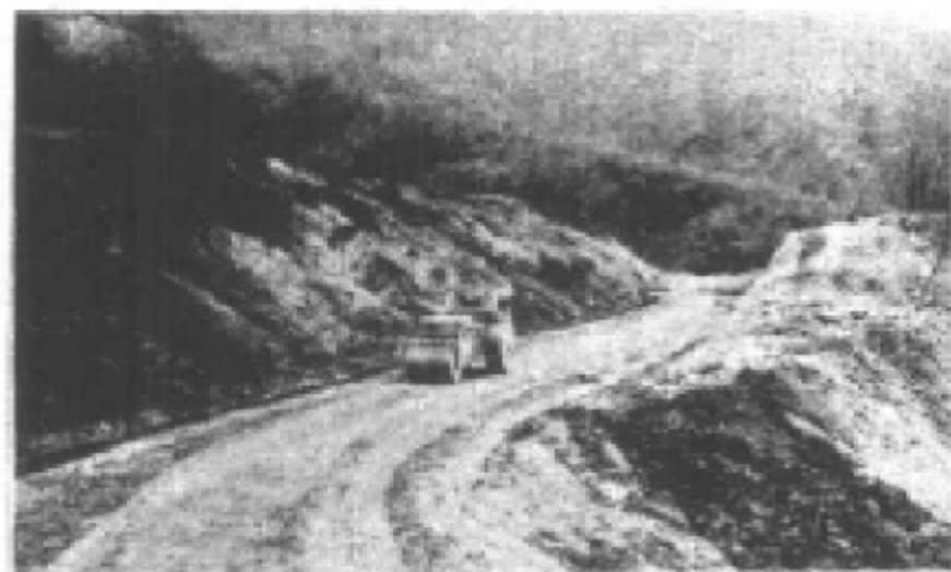
正在施工的水田公路之竹絲梁
