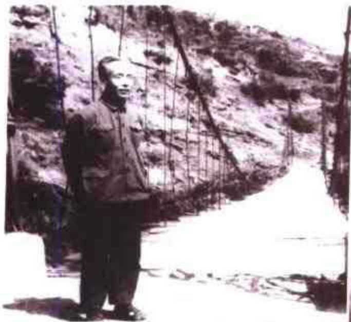
县水电局驻紫云 水库工地技术指 吴文培在他设计 的铁索桥前留影
