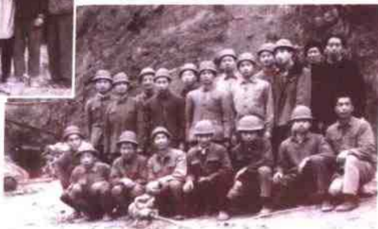
隧洞掘进连全体合影
