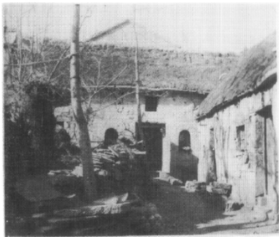
密北抗日民主政府，设在尖山王德昌家西屋三间草房及屋内的三条石券窑洞内。
