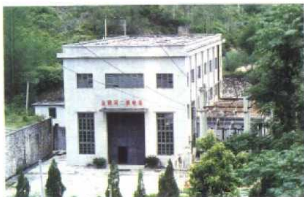
金银河二级电站 设计水头 30.5m, 装机 2 \times 3000\text{KW} , 设计年发电 1800 万千瓦时。
