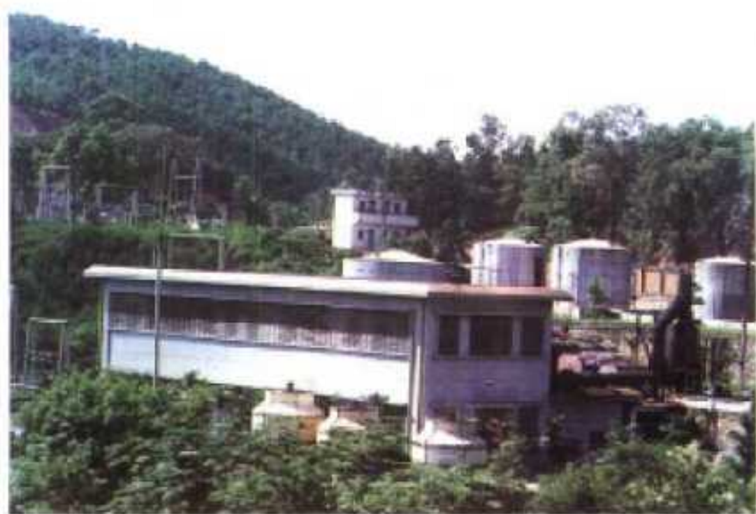
屏风山火电厂 总装机容量 7500 千瓦, 是罗定市电网的调峰电站。
