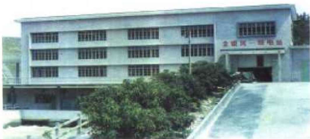
金银河一级电站 设计水头 21m, 装机容量 4 \times 1250\text{KW} , 设计年发电 1713.7 万千瓦时。
