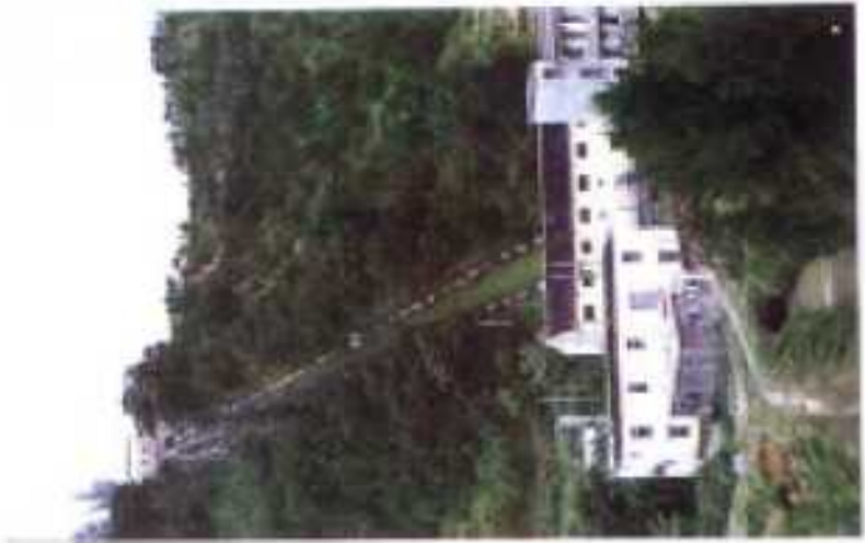
山坝二级电站 设计 水头 72m, 装机 3 \times 500 千瓦, 设计年发电量 420 万千瓦时。
