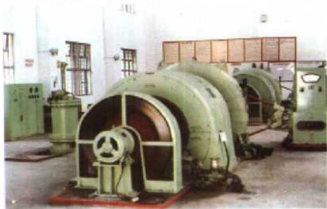
罗光二级电站 设计水头 123.5m, 装机容量 2 \times 2000 千瓦, 设计年发电量 1318 万千瓦时。
