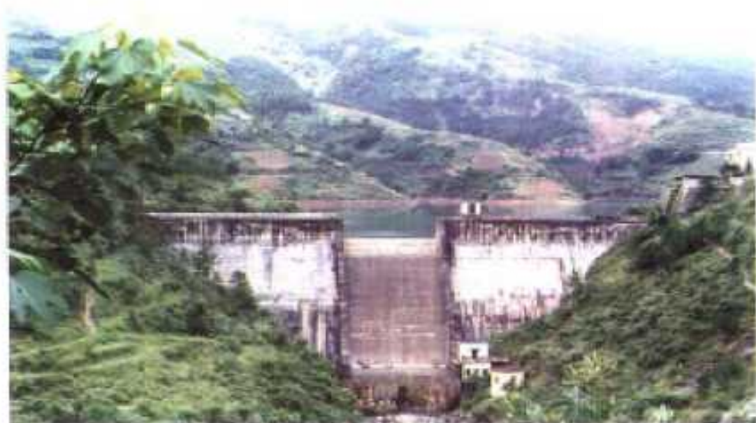
湘塘水库 集雨面积 39.2 平方公里, 总库容 1680 万 m^3 , 是引澧灌区的一个补偿调节水库。图为水库砼重力坝, 坝顶长 125 米, 最大坝高 44 米。
