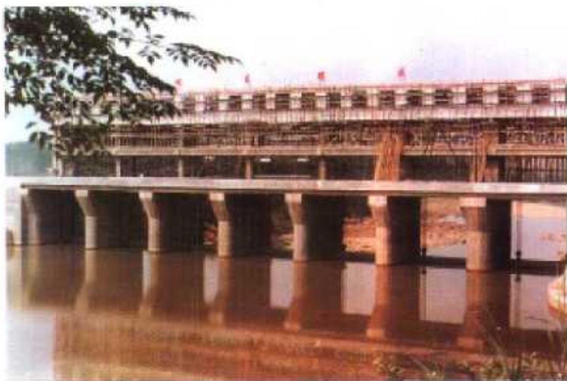
双东水电站 拦河闸坝。
