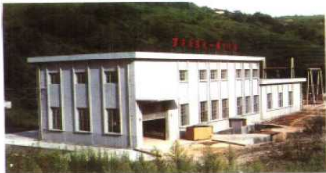
罗光一级电站 总装机容量 2 \times 630 千瓦, 设计年发电 260 万千瓦时。
