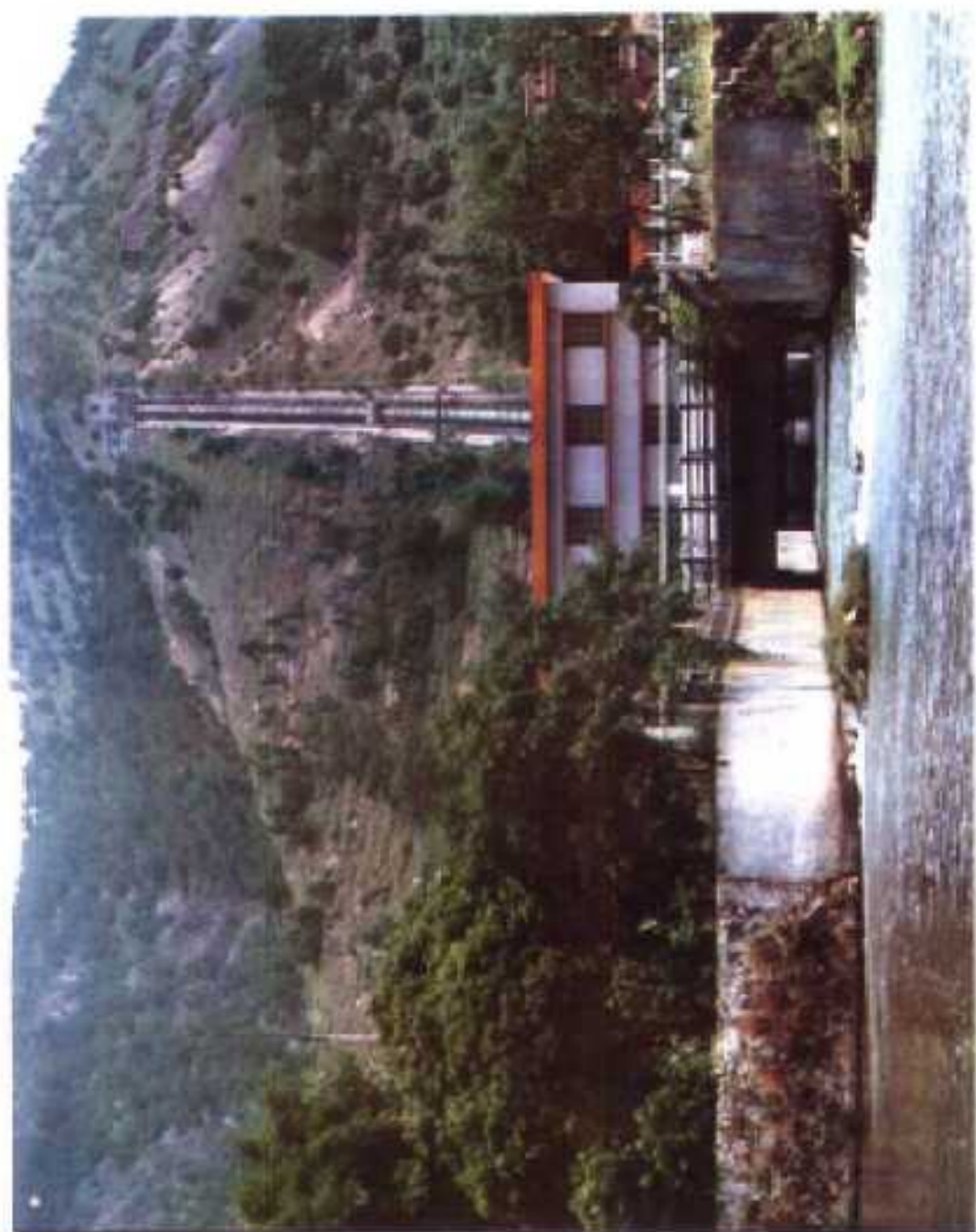
罗光二级电站 设计水头 23.53 装机容量 2 × 2000 千瓦，设计年发电量 2320 万千瓦时。
