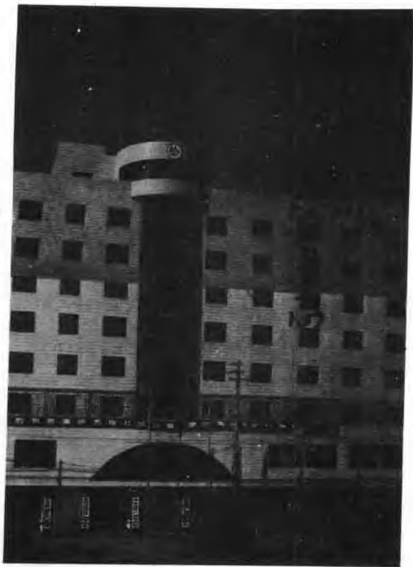
庐山区广播电视中心大楼
