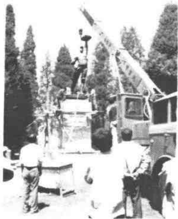
铜像正在安装中
