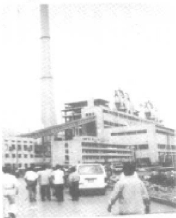
↓ 装机容量为60万 千瓦的盘县电厂主厂 房
