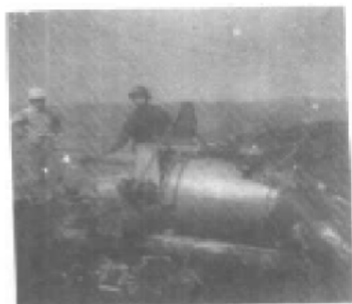
↑ 盘县矿区火铺矿一井区在没有电源情况下，制作手摇风车为矿井通风
