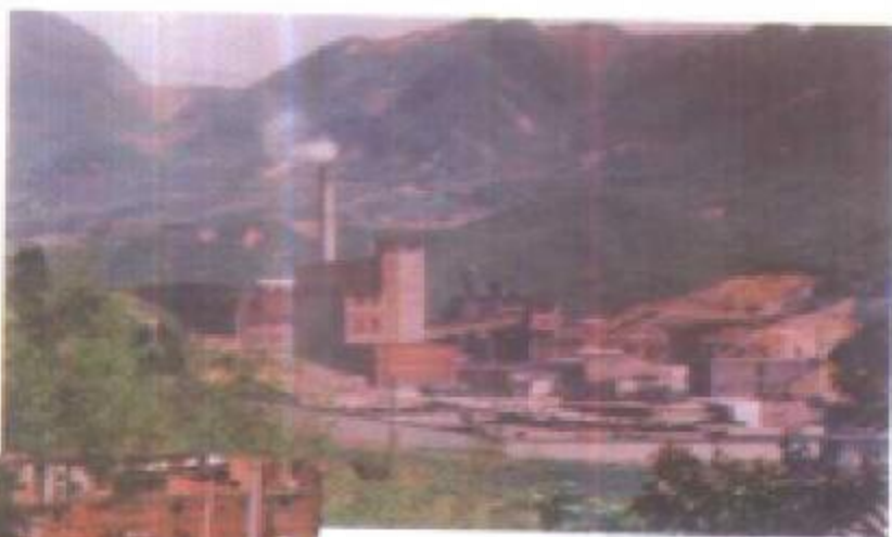
水城水泥厂厂 区一角。该厂“乌 蒙牌”水泥远销东 南亚国家和香港地 区。
