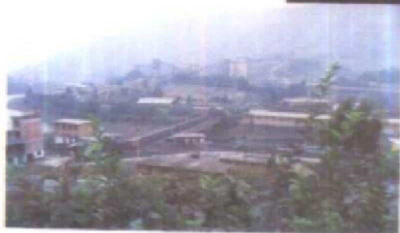
← 盘江矿务局土 城矿工业广场
