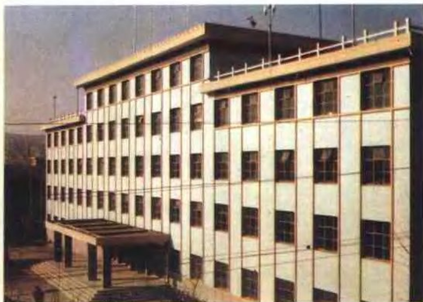
中共临洮县委办公楼
