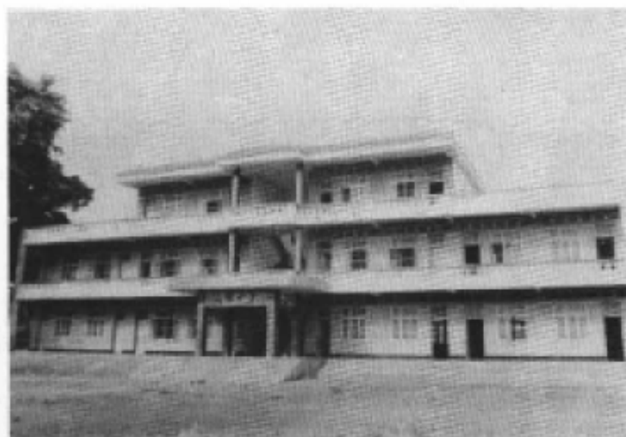
图为1988年群众集资兴建的美珠小学新教学楼
