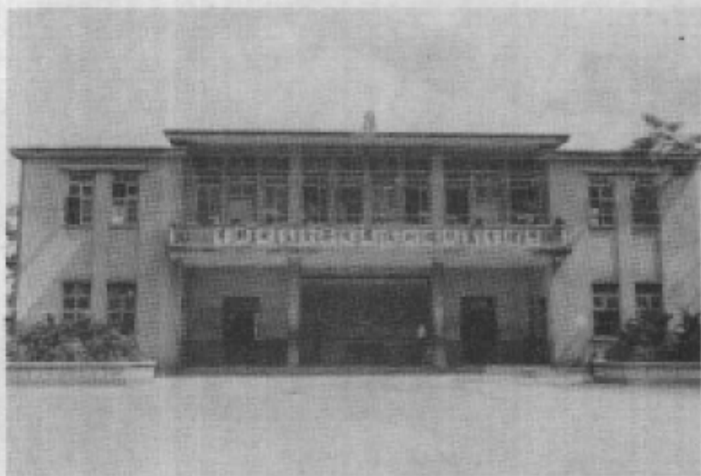
图为临高中学新建办公楼
