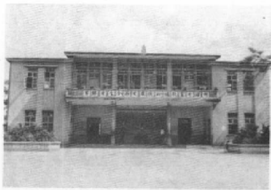
图为临高中学新建办公楼
