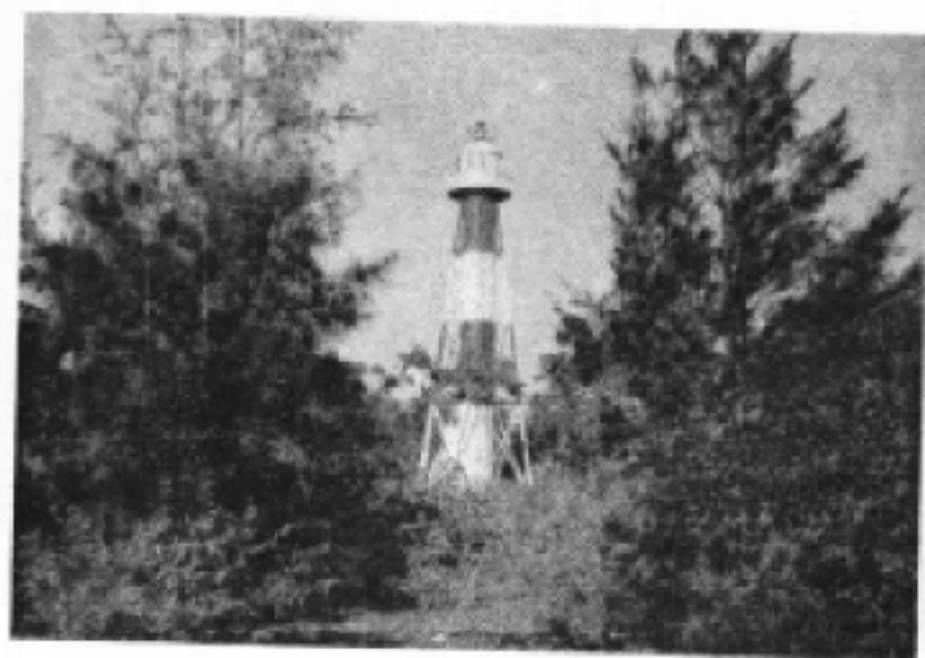
图为临高角上的铁灯塔。
