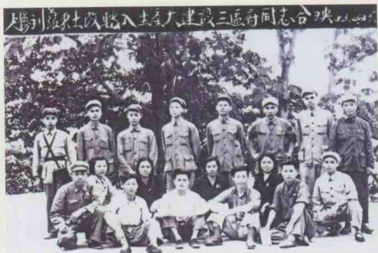
胜利完成土改后第三区人民政府全体同志合影， 前排中区祥（副区长）
