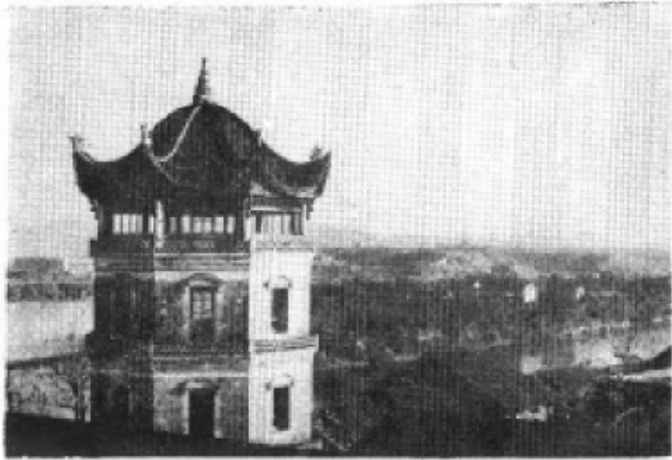
耒阳城摄影（八角亭一角）
