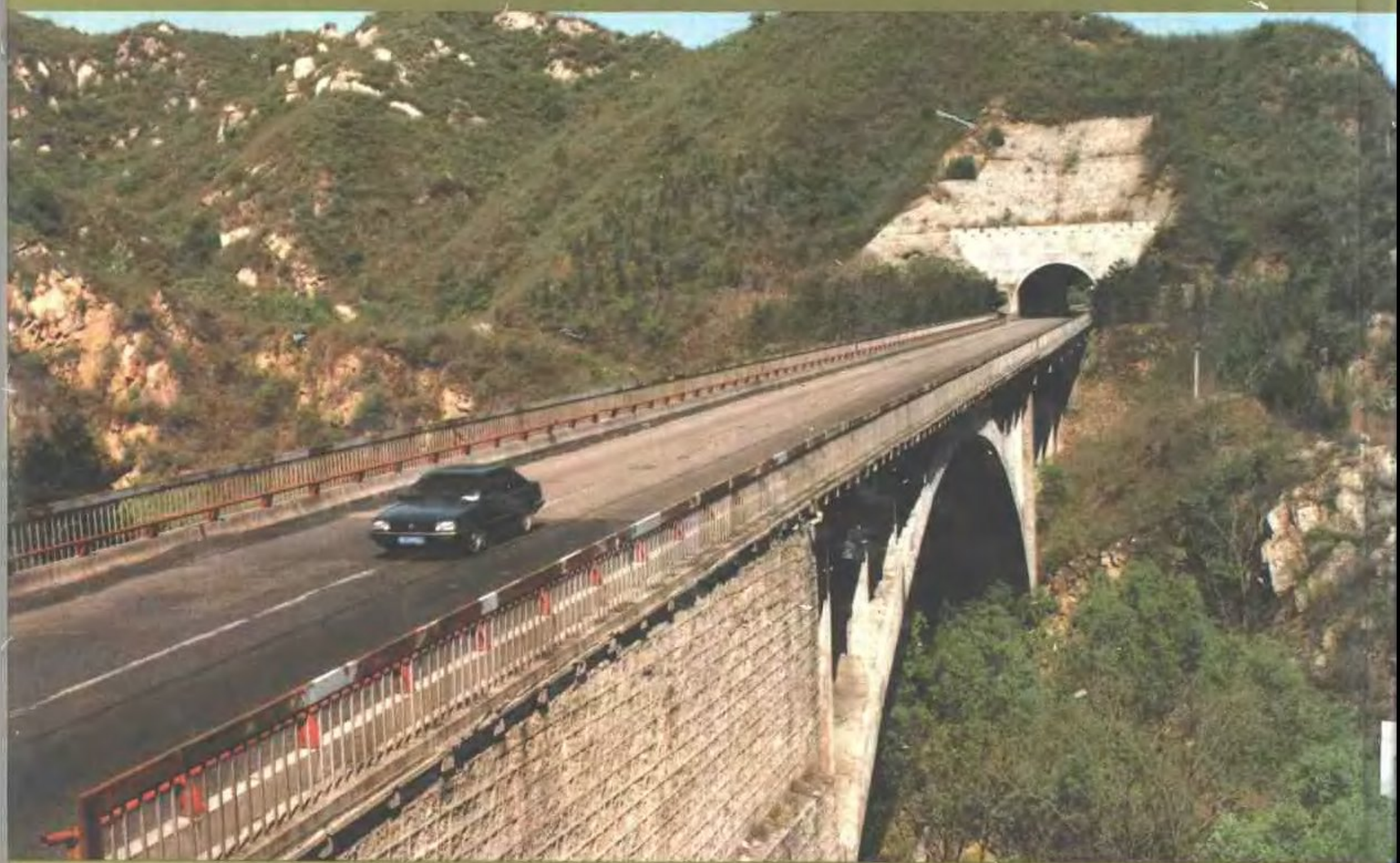
延庆分局承建的110国道陡岭一号大桥
