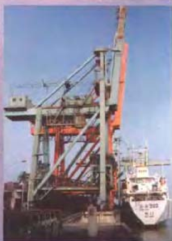
▲ 台州电厂煤码头
