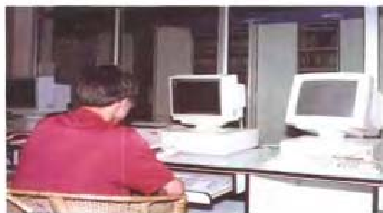
▲电信局程控机房
