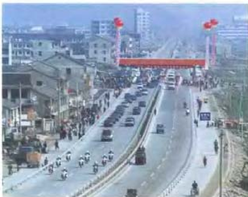
▲大环线拓宽工程建成
