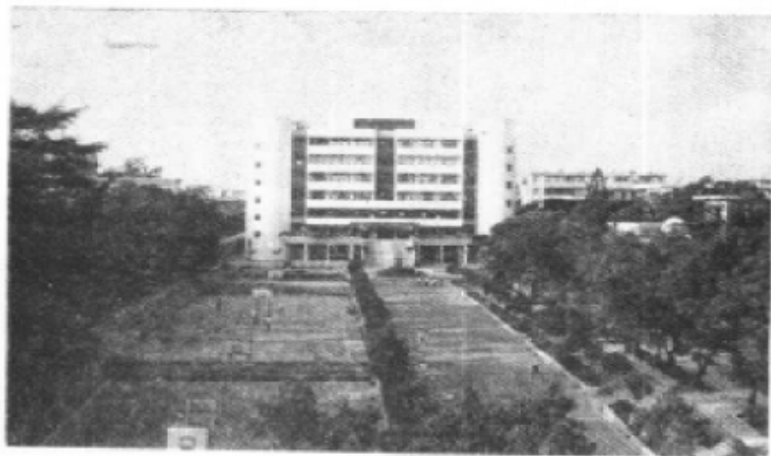
江门一中教学中心大楼
