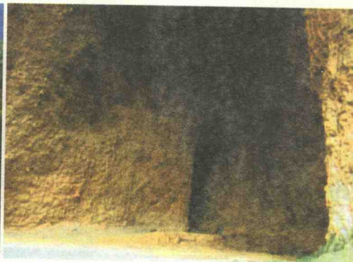
被挖成了穹拱状的大型隧道
