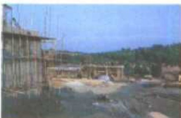
建設中的靖海鎮大型自來水工程
