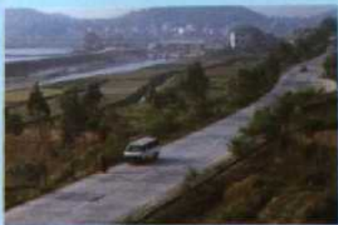
▲ 龐(口)古(勞)水泥公路
