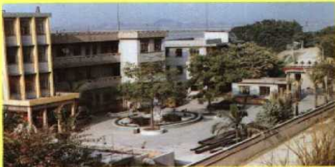
鶴山自來水公司東坡 自來水廠生活區
