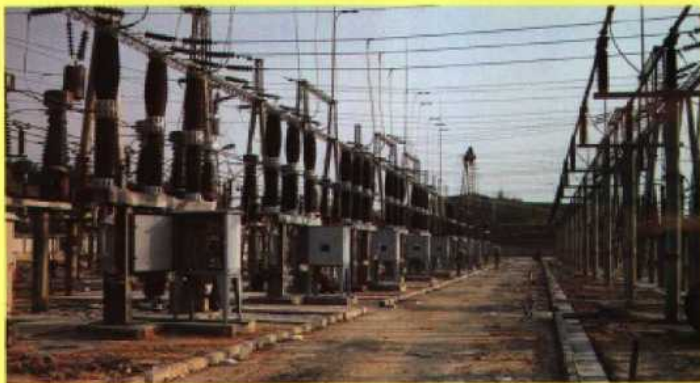
▲ 正在興建中的220KV鶴山變電站
