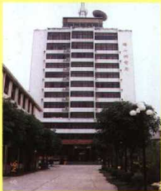
▲ 鶴山市供電局電力調度中心大樓
