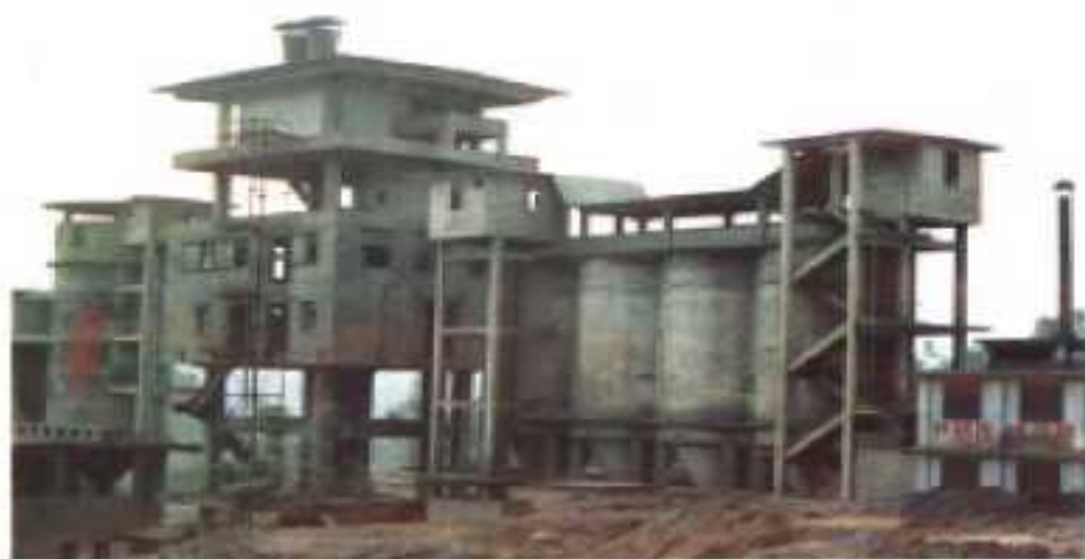
和平水泥厂 上图是月产6000吨水泥的新生产线。
