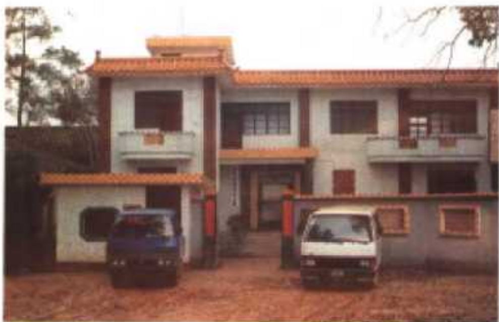
和平 106 厂办公大楼 该厂主要生产烟花、爆竹系列。
