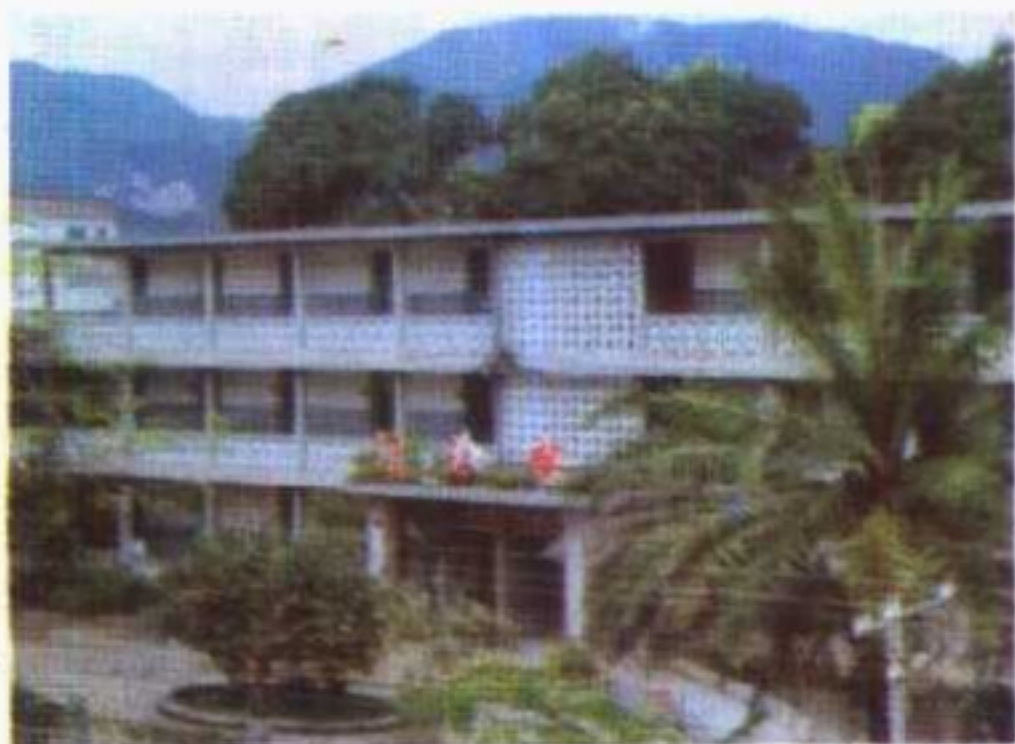
← 县人民医院门诊部
