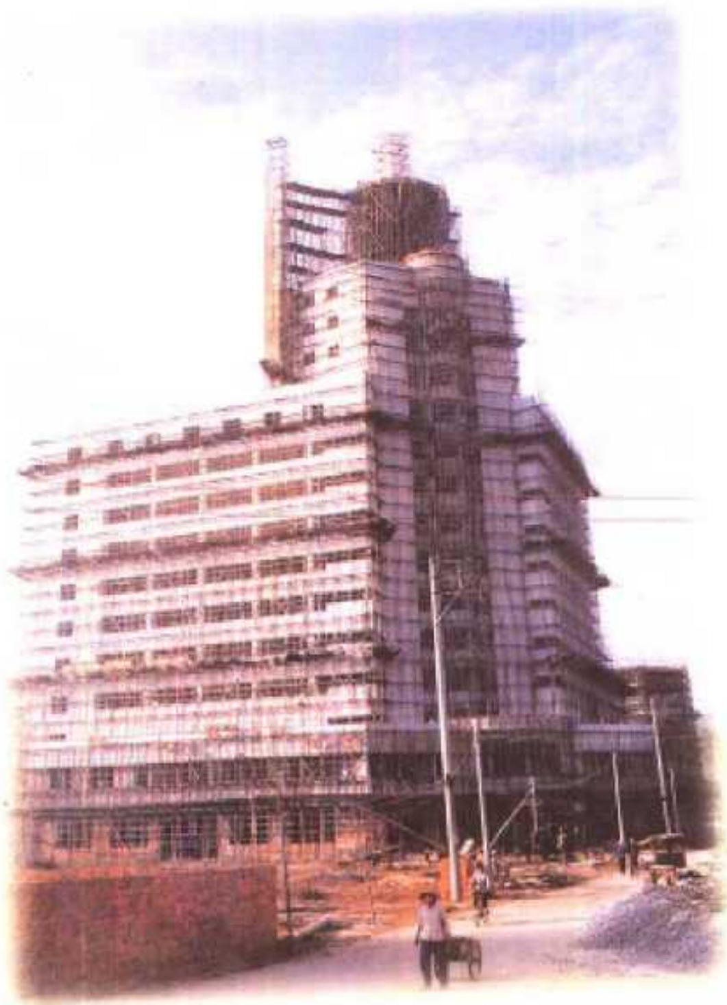
在建中的广宁邮电大楼
