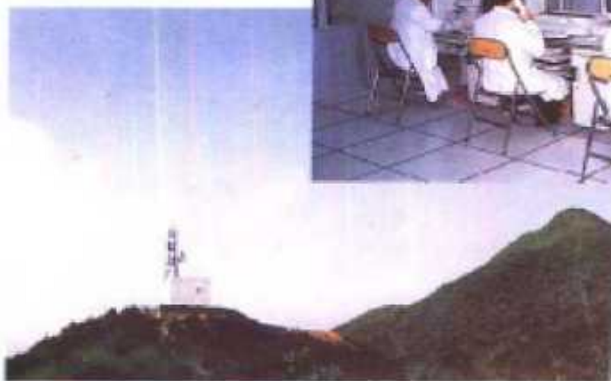
△石马山数字微波通信站
