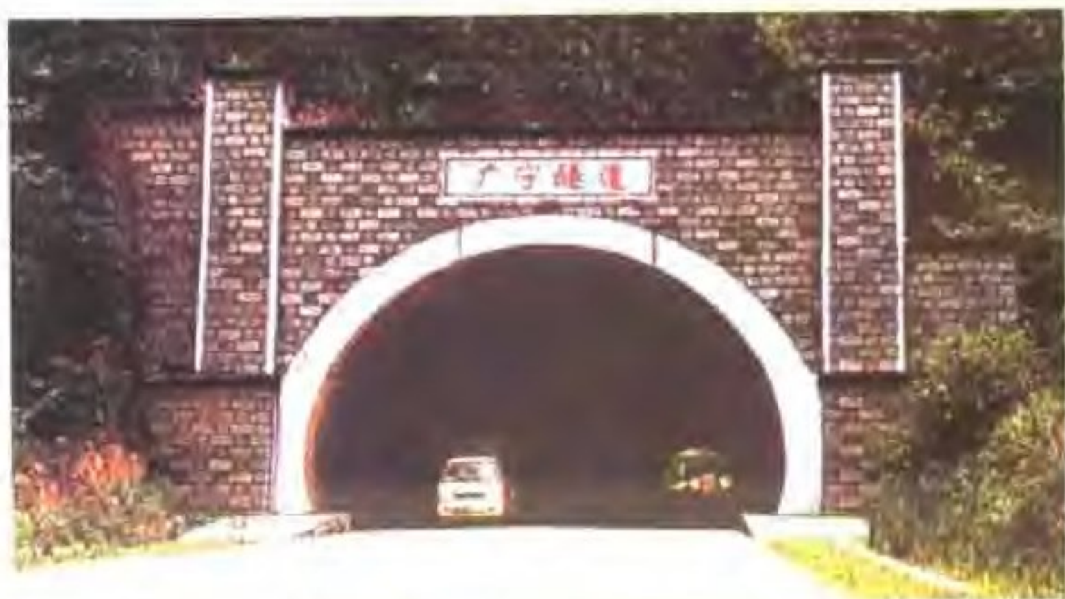
省道连大公路隧道——广宁隧道。
