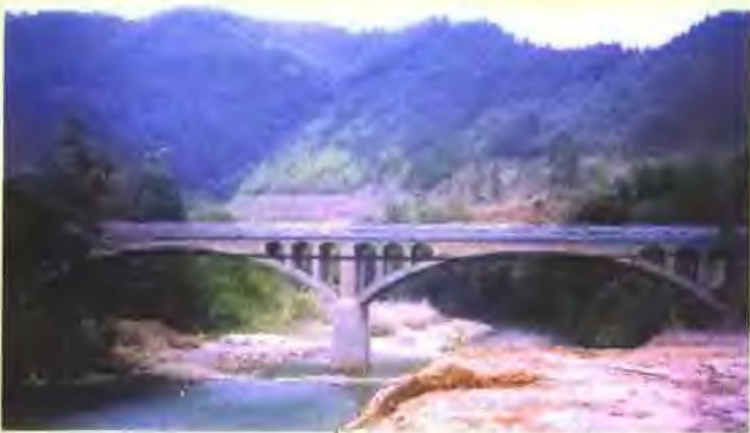
赤坑福 排马口铁索 桥侧新建的 永久水泥桥。
