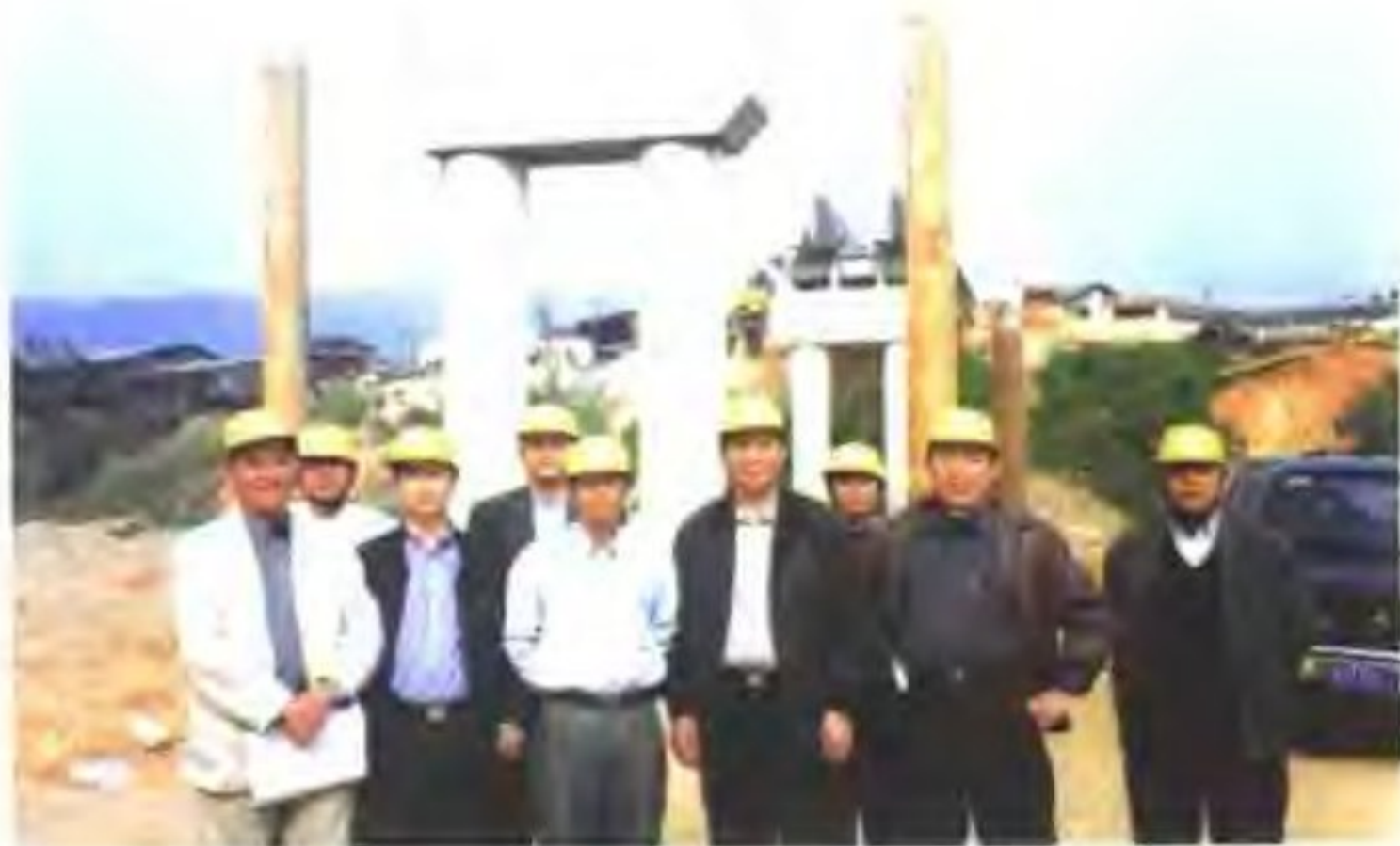
2001年9月，县交通局、公路局领导到古水大桥施工现场指导工作。
