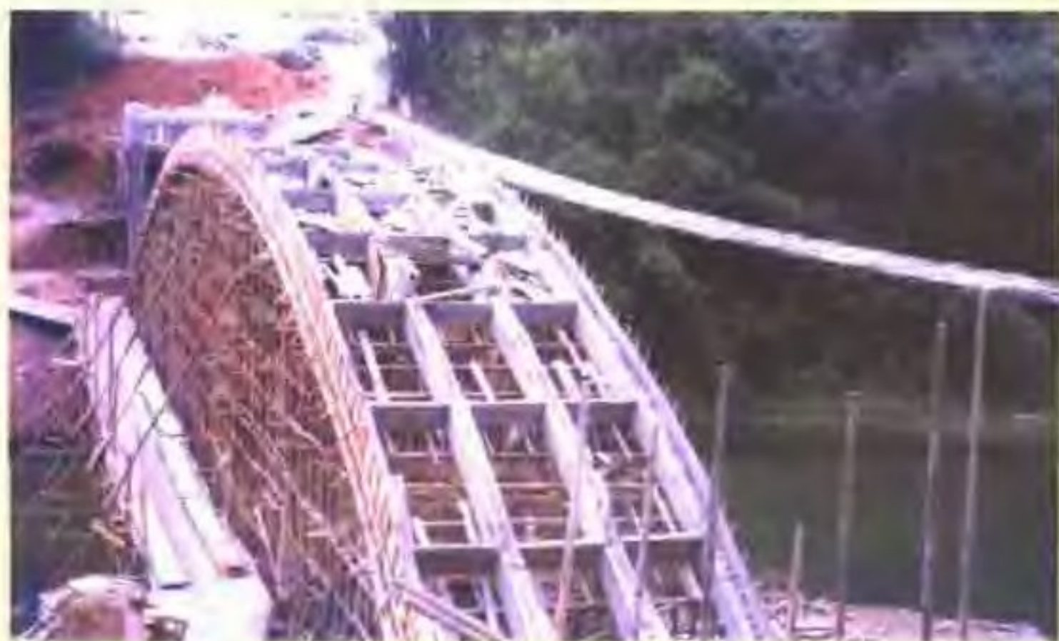
老区铁索桥改造施工现场。
