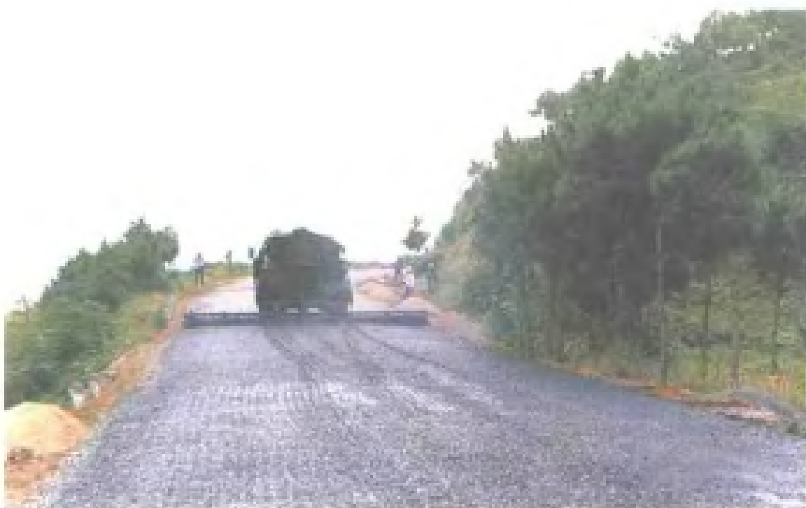
沙吕线铺上柏油路面
