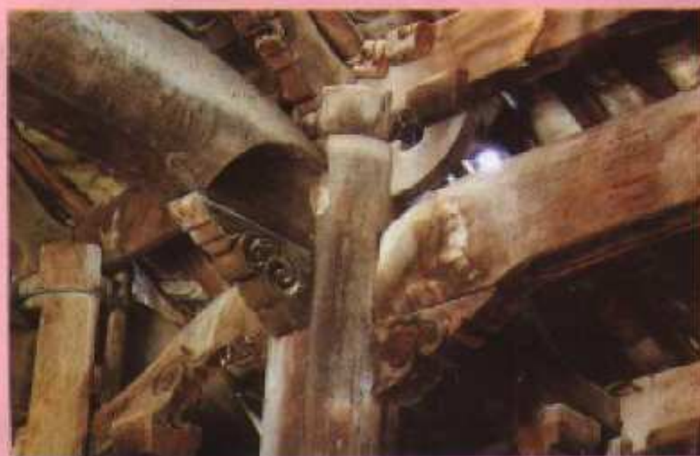
◁ 古建筑艺术的一绝,大梁宫内部木梁结构。(李锦秋摄)
