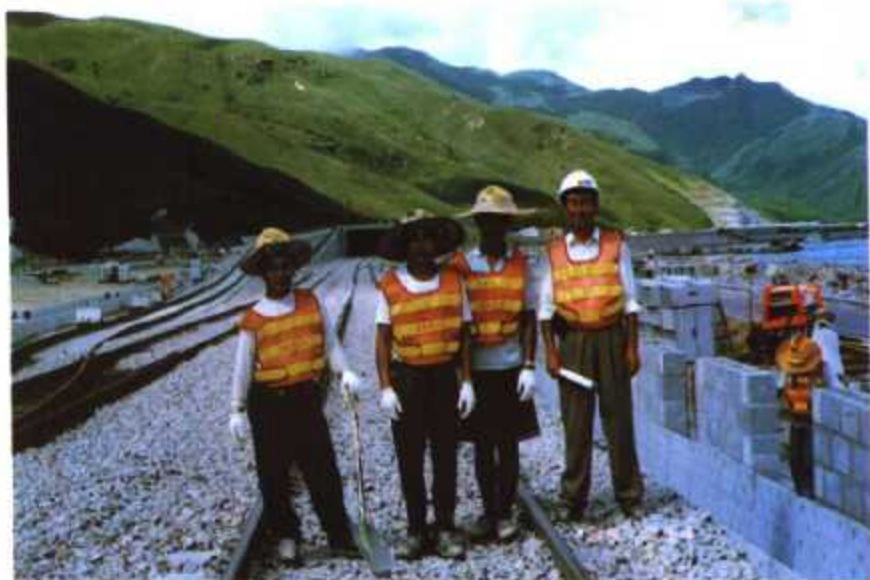
▲福建省对外劳务合作公司派往香港修建新机场铁路的劳工
