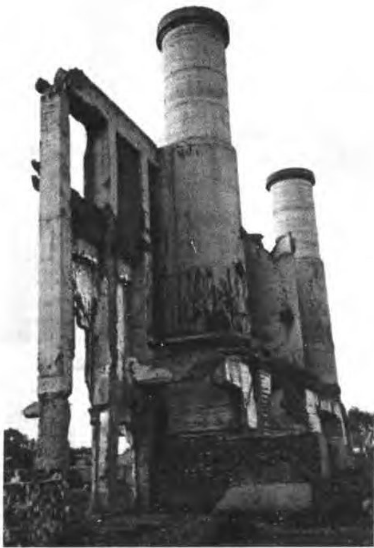
731 部队锅炉房遗迹(哈尔滨市平房区)
