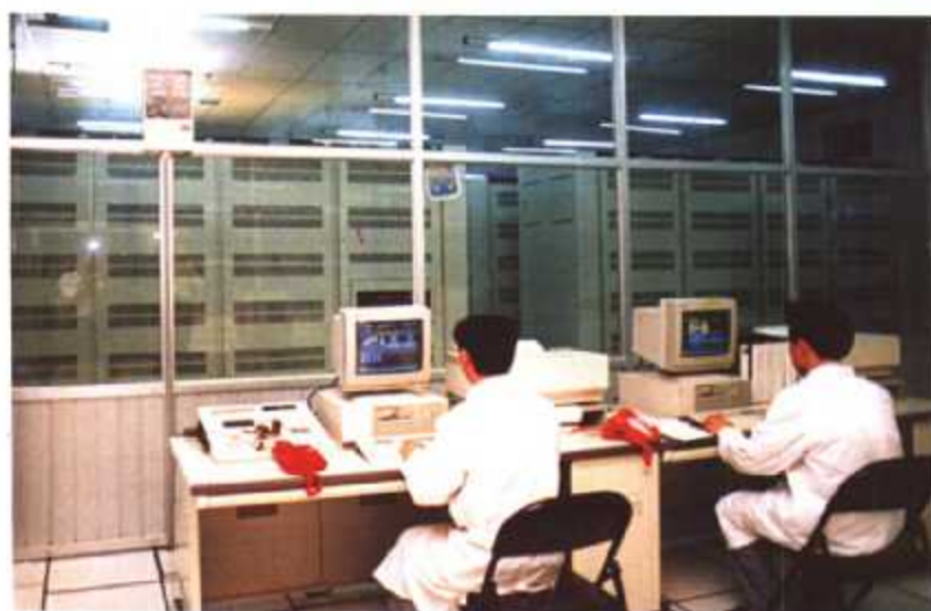
福州电信局引进日本富士通 F-150 型 5 万门程控电话交换机机房
