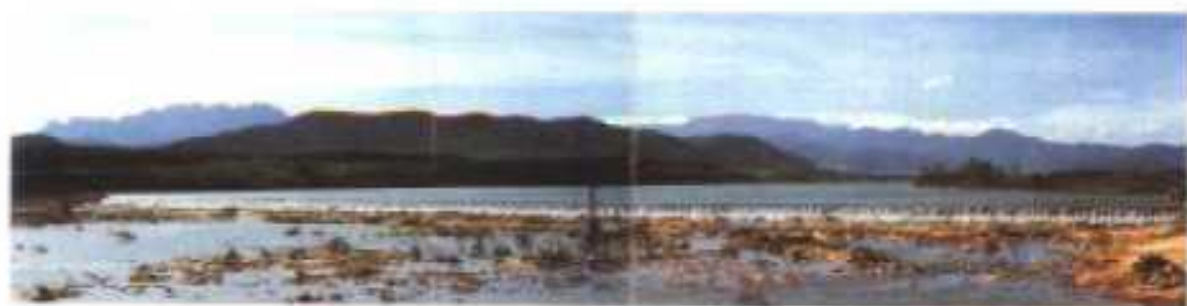
东方电站的拦河坝
