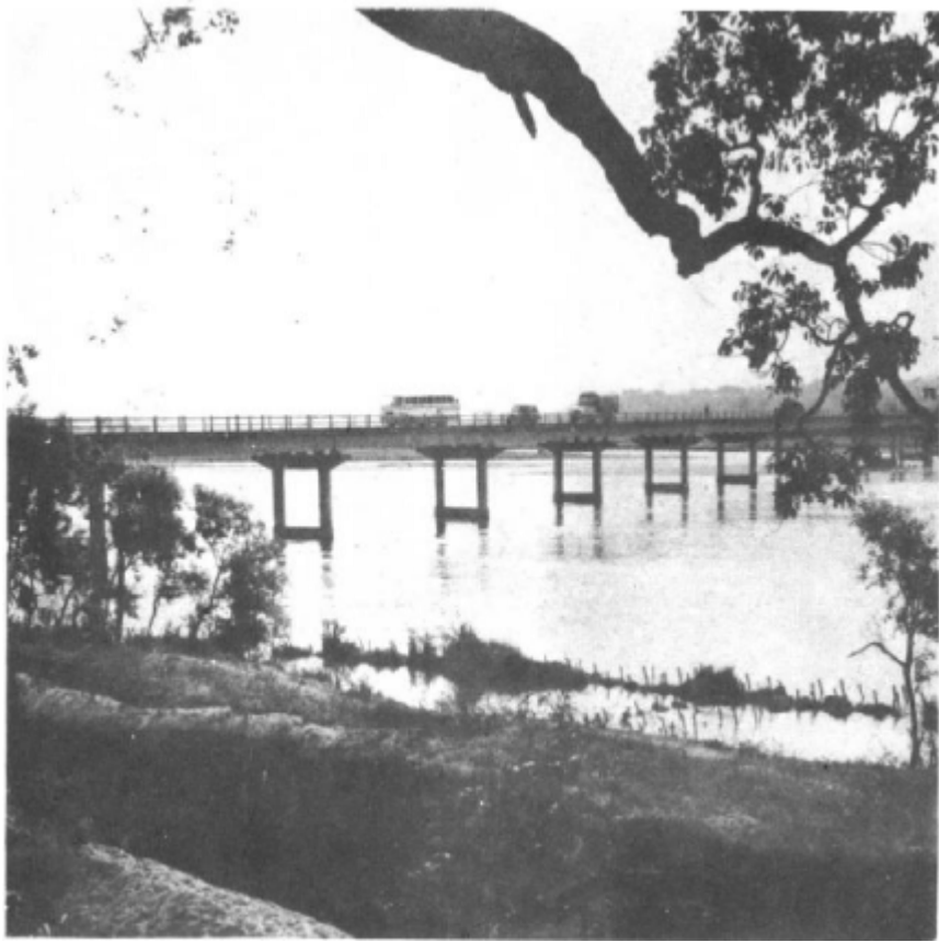
盈江拉虎练桥 位于距盈江县城约三公里的大盈江上，为17孔钢筋混凝土结构，全长371米，宽七米，是云南省目前最长的公路桥，于1976年建成。
