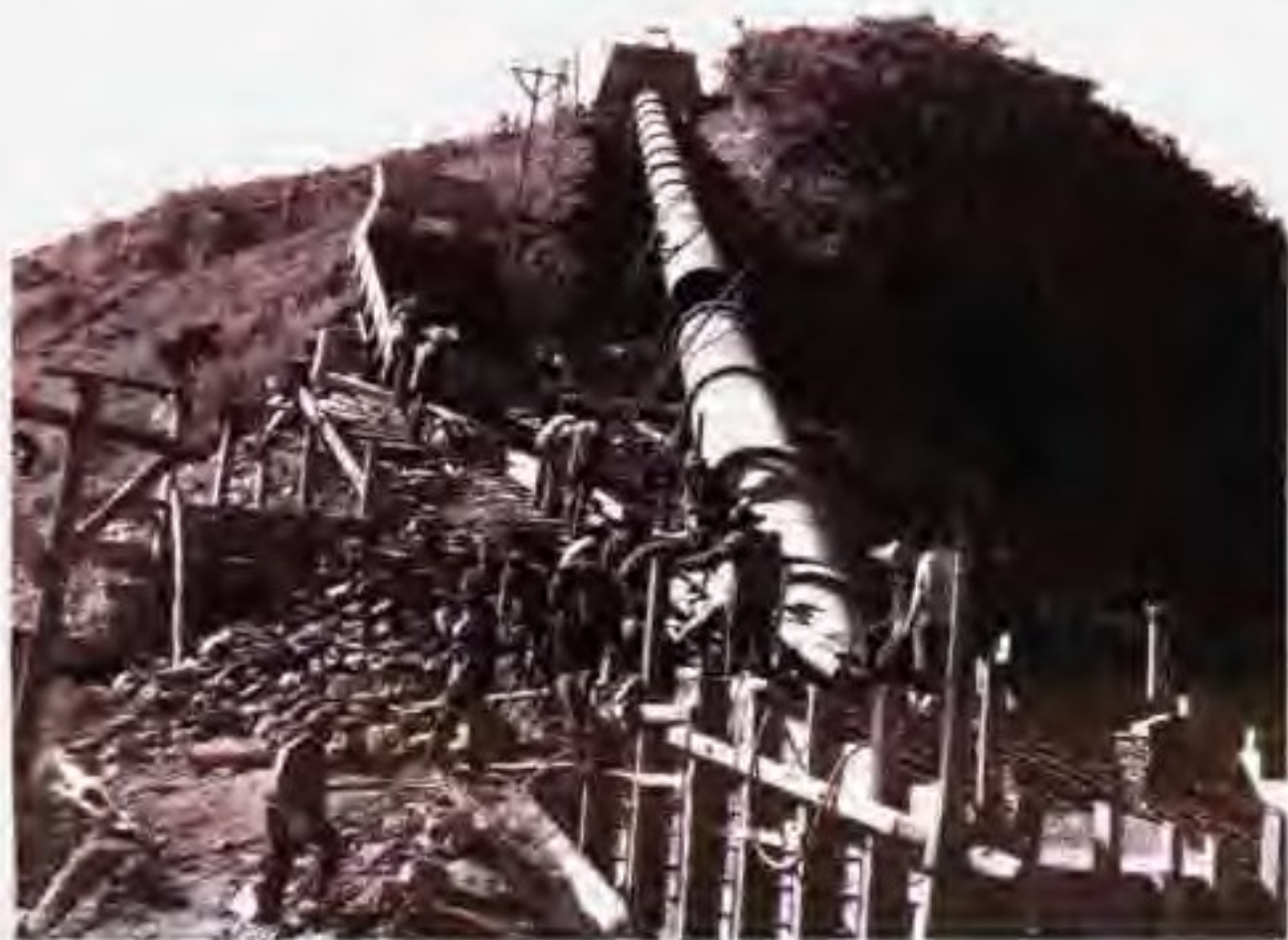
1986年建成的丙巷河倒虹吸工程
