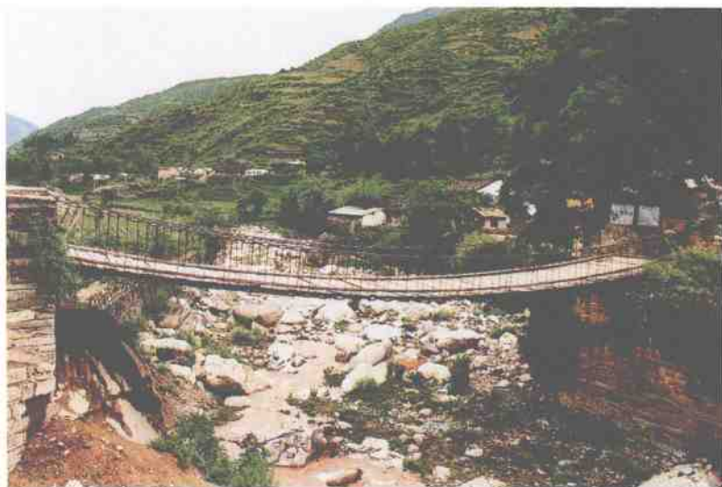
大理太邑铁索桥——位于大理市太邑村，建于清光绪二十六年（1900年）
