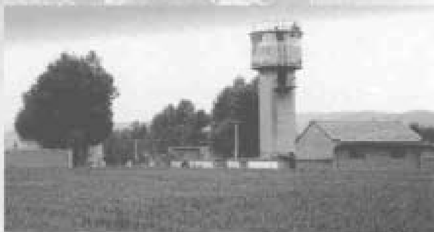
人饮井及水塔
