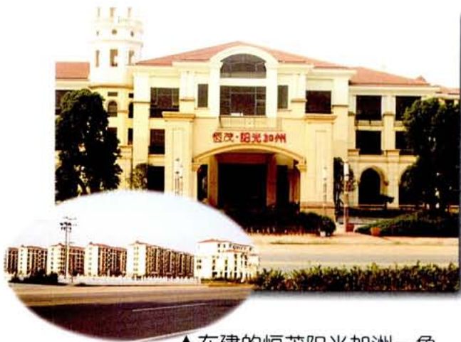
▲ 在建的恒茂阳光加洲一角
