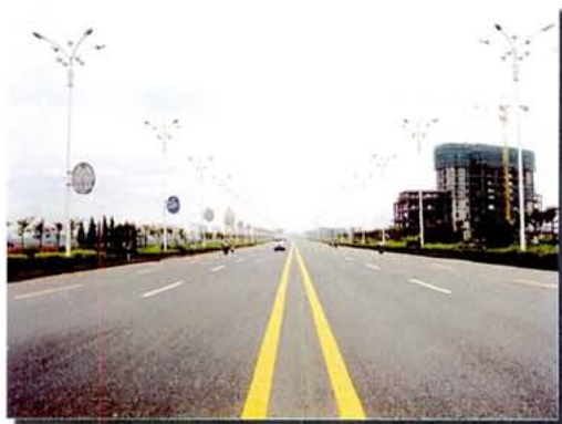
▲ 2003年7月10日南安一级公路竣工通车
