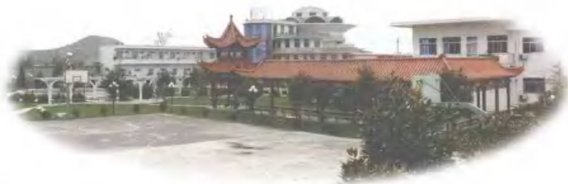
安顺开发区水厂（摄于2006年）
