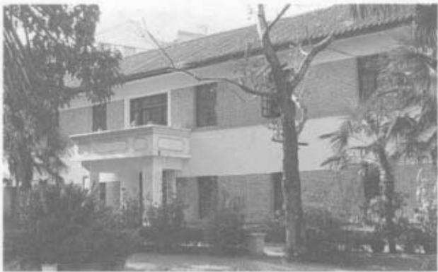
安宁市文物保护单位——解放初期建 盖的安宁县委办公楼(近代)
