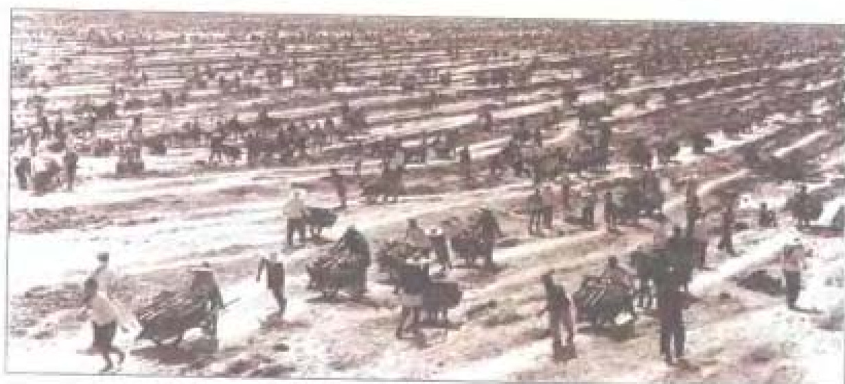
70年代怀洪新河双沟切岭施工
