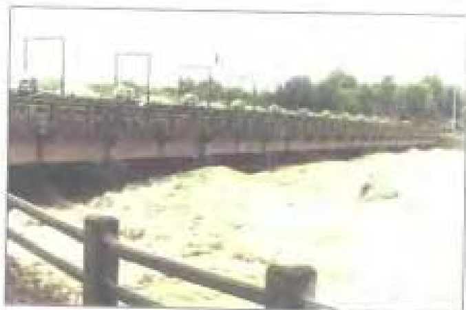
豫皖苏洪工程——王家坝进水闸
