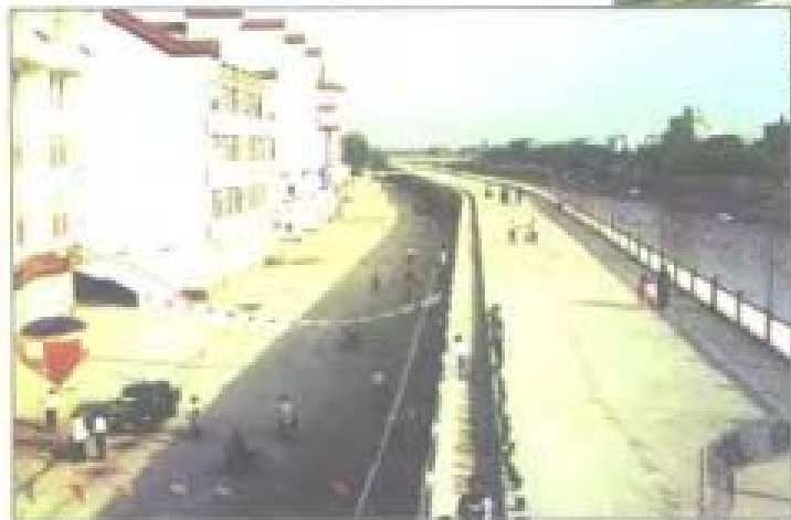
芜湖市多功能防洪墙
