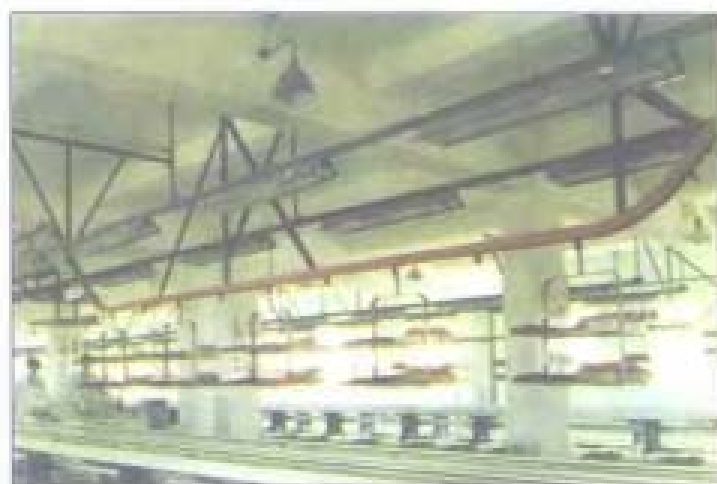
合肥美菱电冰箱配件总厂三分厂生产车间
