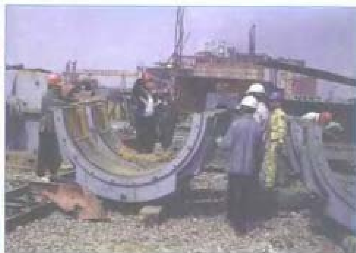
安庆电力技工学校实习现场
