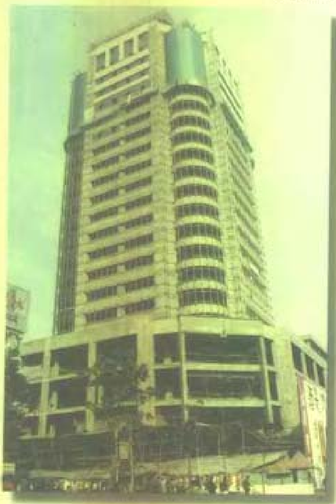
新建安徽省外经贸委、粮油食品进出口集团公司办公大楼即将竣工（1997年）
