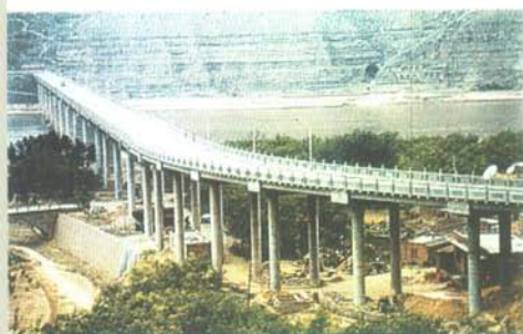
△ 连接晋、陕的佳临大桥
