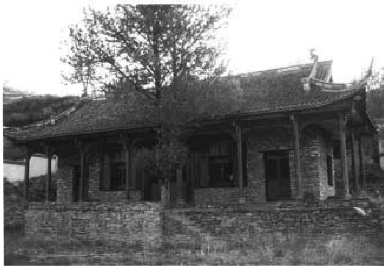
中共中央政治局两河口会议遗址——关帝庙大殿
