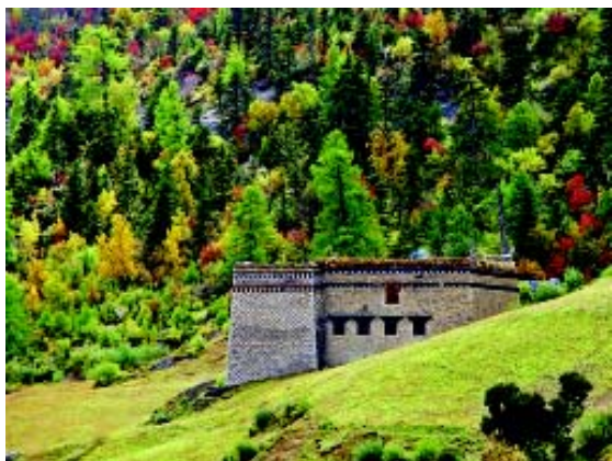
④ 亚丁地区的藏式碉楼。
