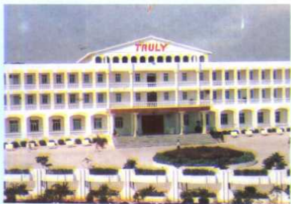
林伟华先生的信利电子工业城办公大楼
