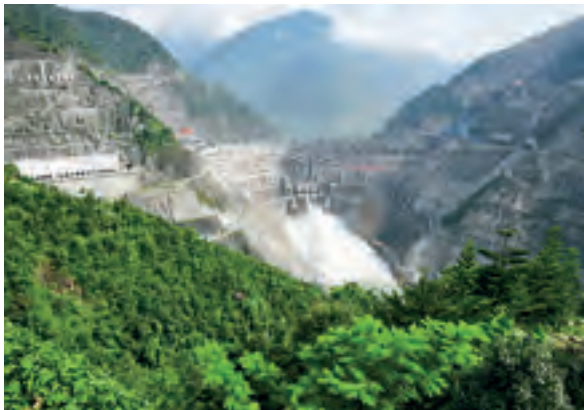
9月25日，小湾水电站首台机组投产发电
