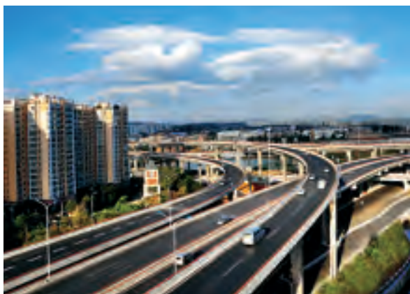
昆明市石虎关立交桥
