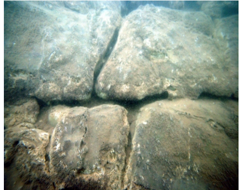
抚仙湖水下建筑物的表面结构之一
