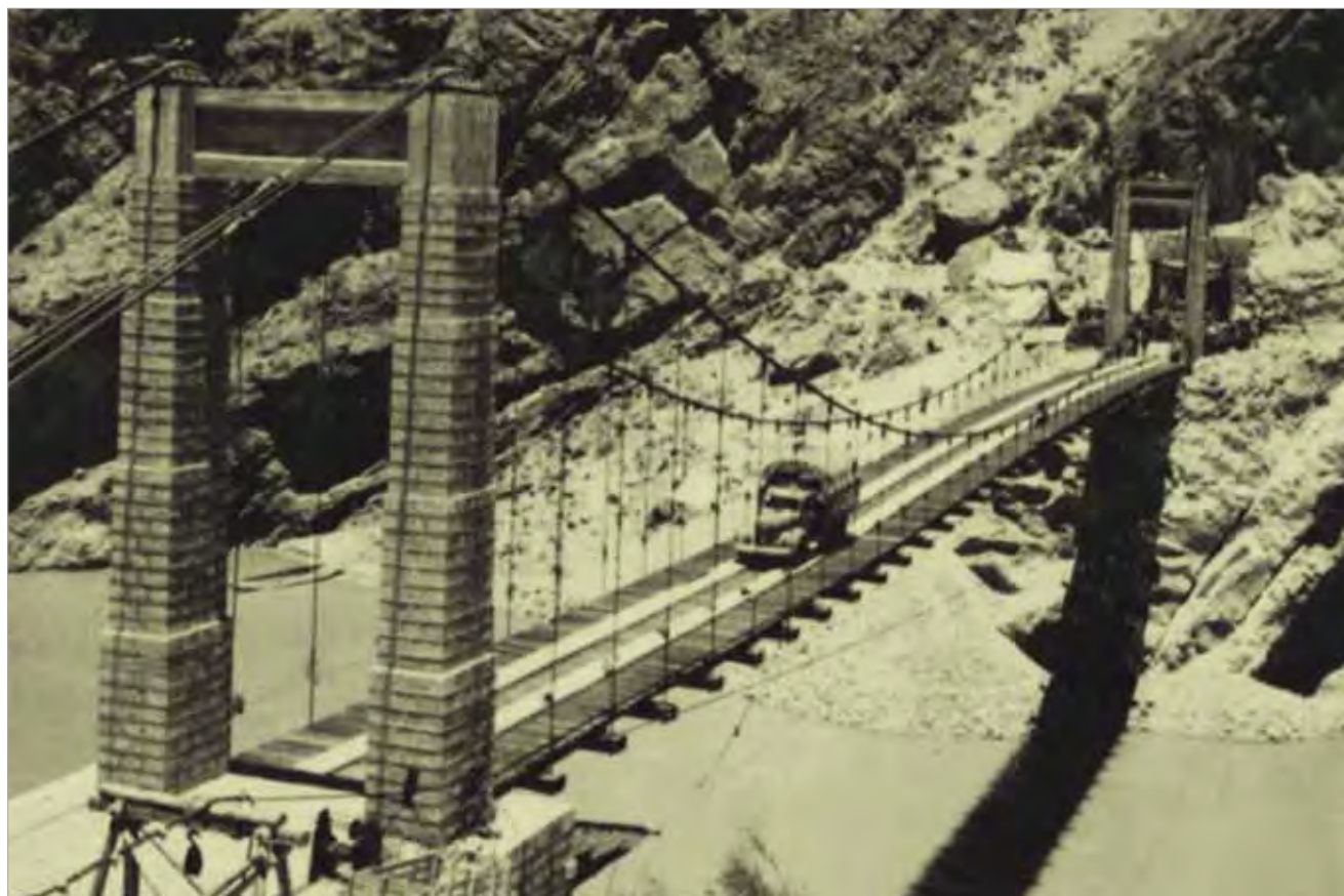
1959年建成的伏龙桥，架设在金沙江上，距中甸县城66公里，东岸为尼西上桥头，西岸系德钦奔子栏。
