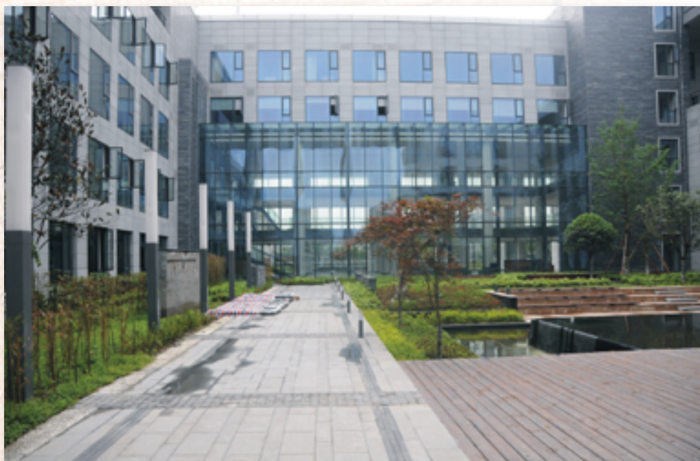
川润成都工业园办公楼
