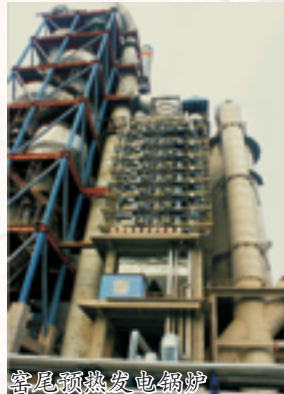
密尾预热发电锅炉
