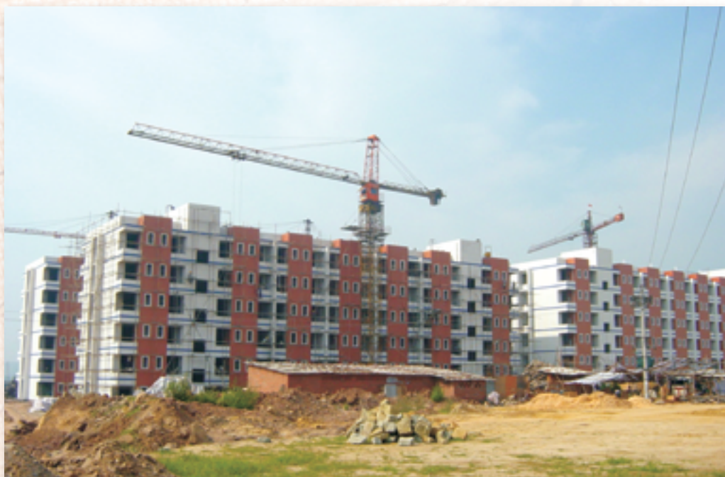
2003年，川润集团承建的四川理工学院学生公寓
