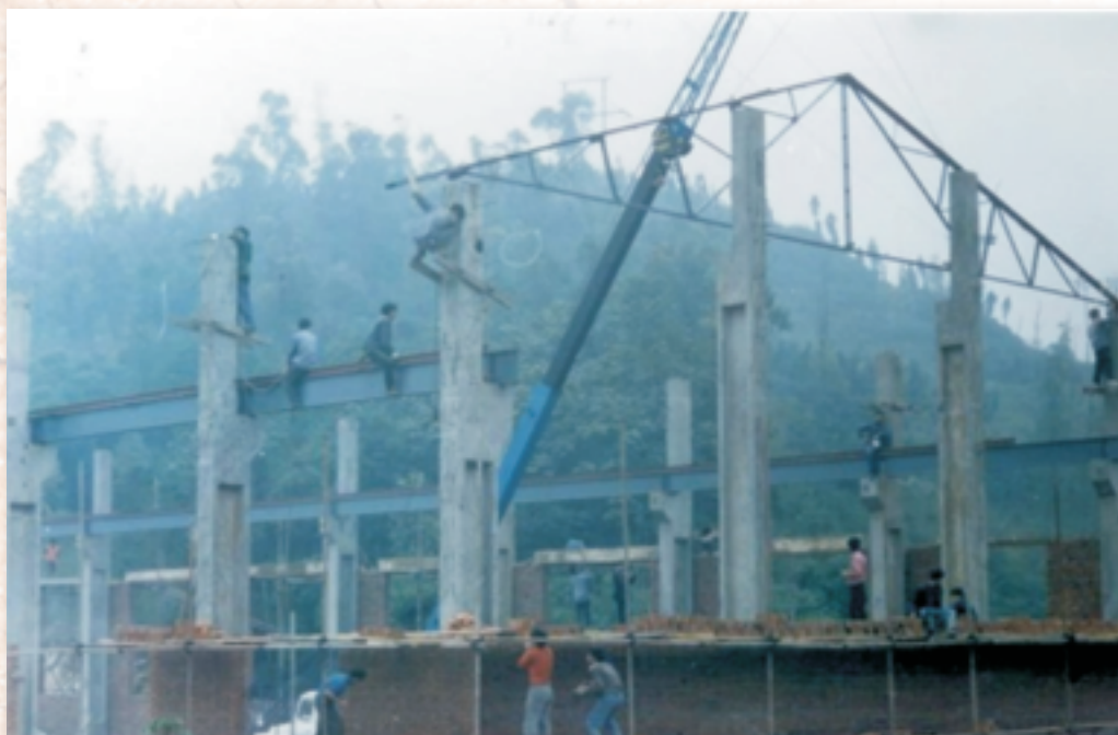
1995年，建设中的自贡西南润滑设备厂
