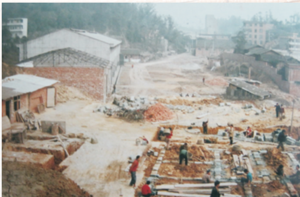
1996年，建设中的自贡西南润滑设备厂办公楼
