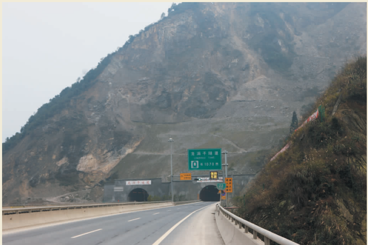
都映高速公路龙洞子隧道出口(恢复重建后)
