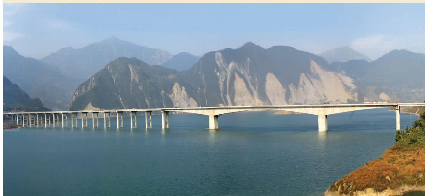
都映高速公路庙子坪特大桥(恢复重建后)
