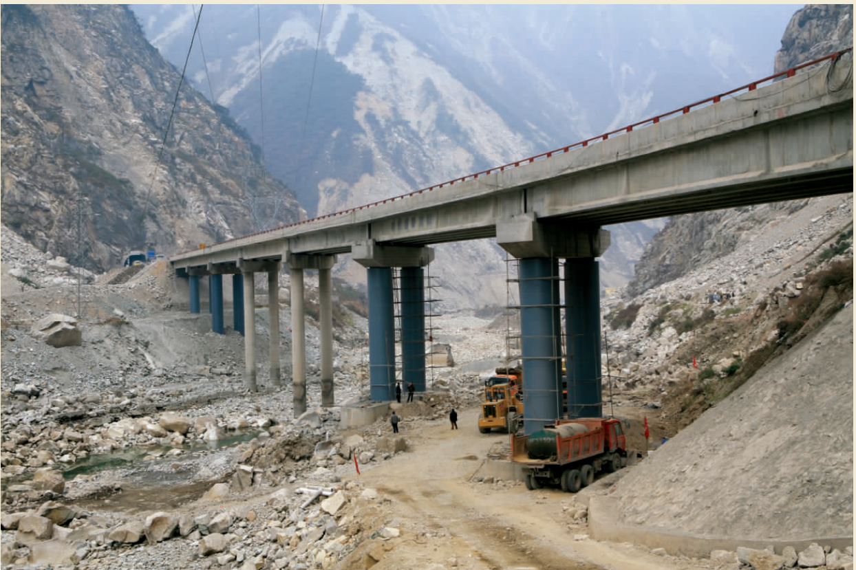
映秀至汶川二级公路彻底关大桥(恢复重建后)
